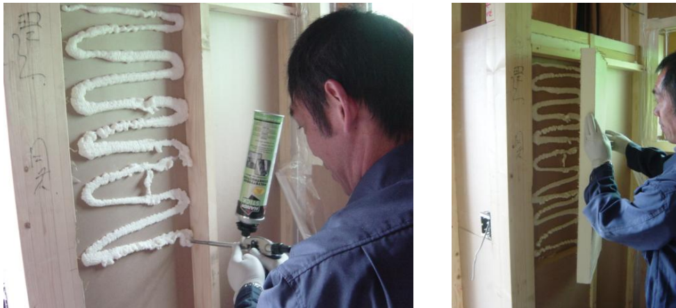
#H450G を利用した施工の様子
