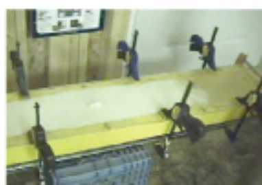
クランプ留めによる注入・充填
